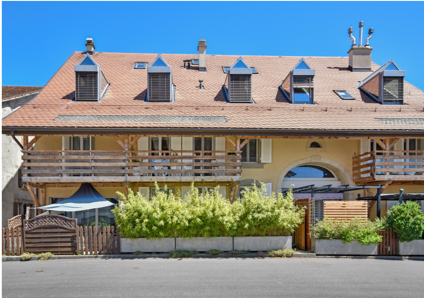
PPE côté terrasses
